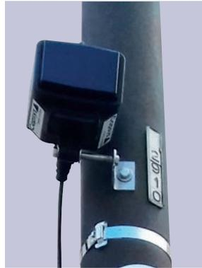
Radar de vitesse et détection de bouchons.
