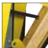
Sangles renforçant le maintien de la façade
