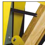
Sangles renforçant le maintien de la façade
